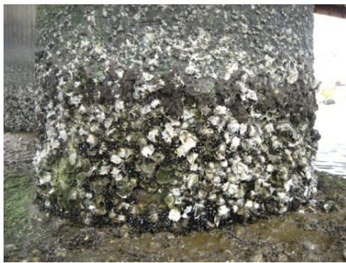
図5 九反田橋の橋脚
